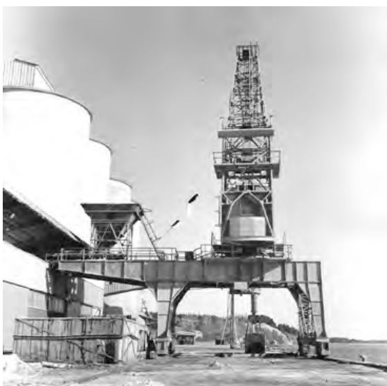
De två första cementsilorna med skopelevatorbyggnaden i förgrunden. Till höger syns den eternitinklädda utlastningsanordningen för lastning av löscement i båtar. Bakom silorna kommer de tre parallella rör där cementet transporterades pneumatiskt från kvarnhuset till cementsilorna.
