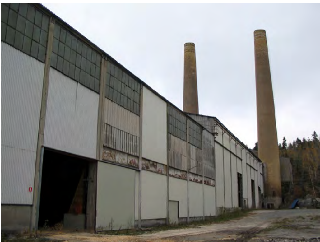
Ugnshusets östra fasad. Även den är delvis inklädd med plåt. Den ursprungliga fönsterraden finns fortfarande kvar.
