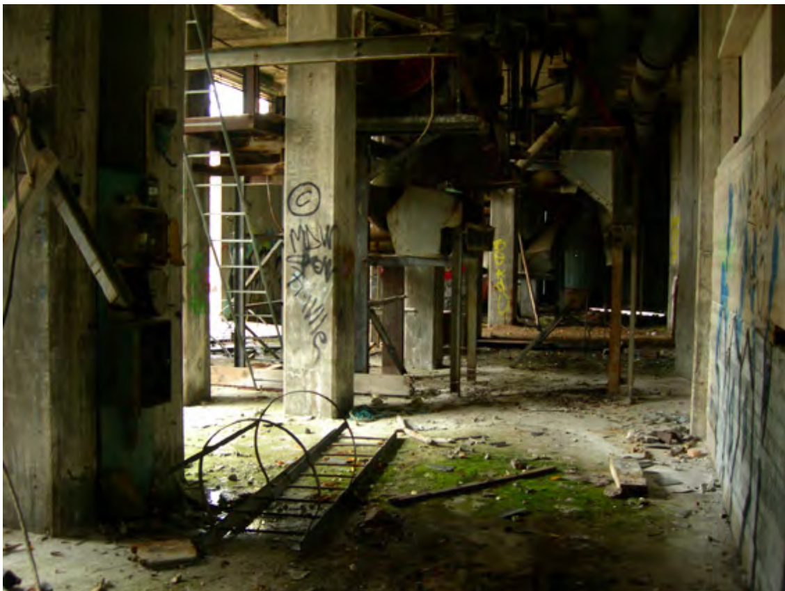
Bilden visar nedre planet under själva silorna. Här matades stenen ut för att sedan transporteras vidare med linbanan. Foto: LKU
