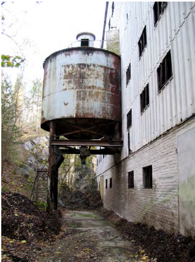
Utlastningsanordning utanför ugnshusets norra vägg. Anordningen hörde till den elektrofilteravdelning som fanns inne i byggnaden.
