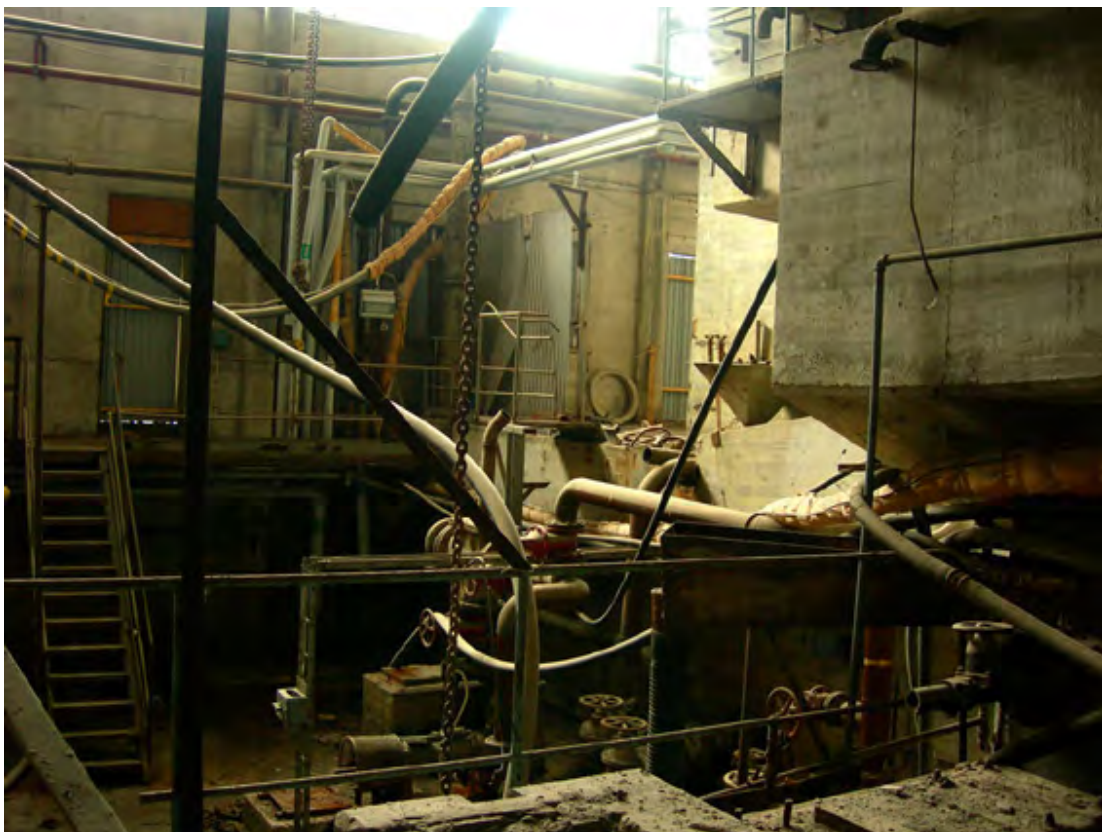
Interiörbild från flotationsanläggningens bottenvåning. En stor del av pumptrustningen saknas, kvar finns rostiga rörledningar och fundament.
