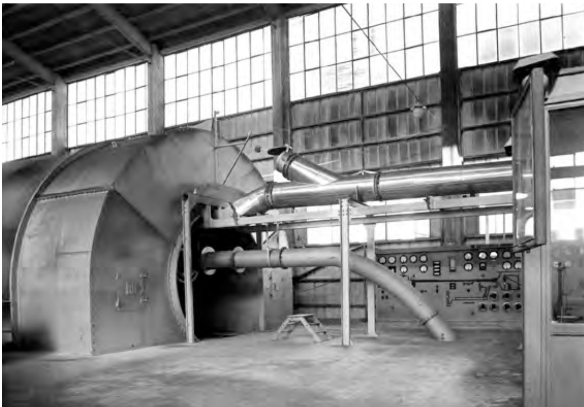
Det färdigmalda råslammet matas in i en av de roterande cementugnarna vid Stora Vika.
