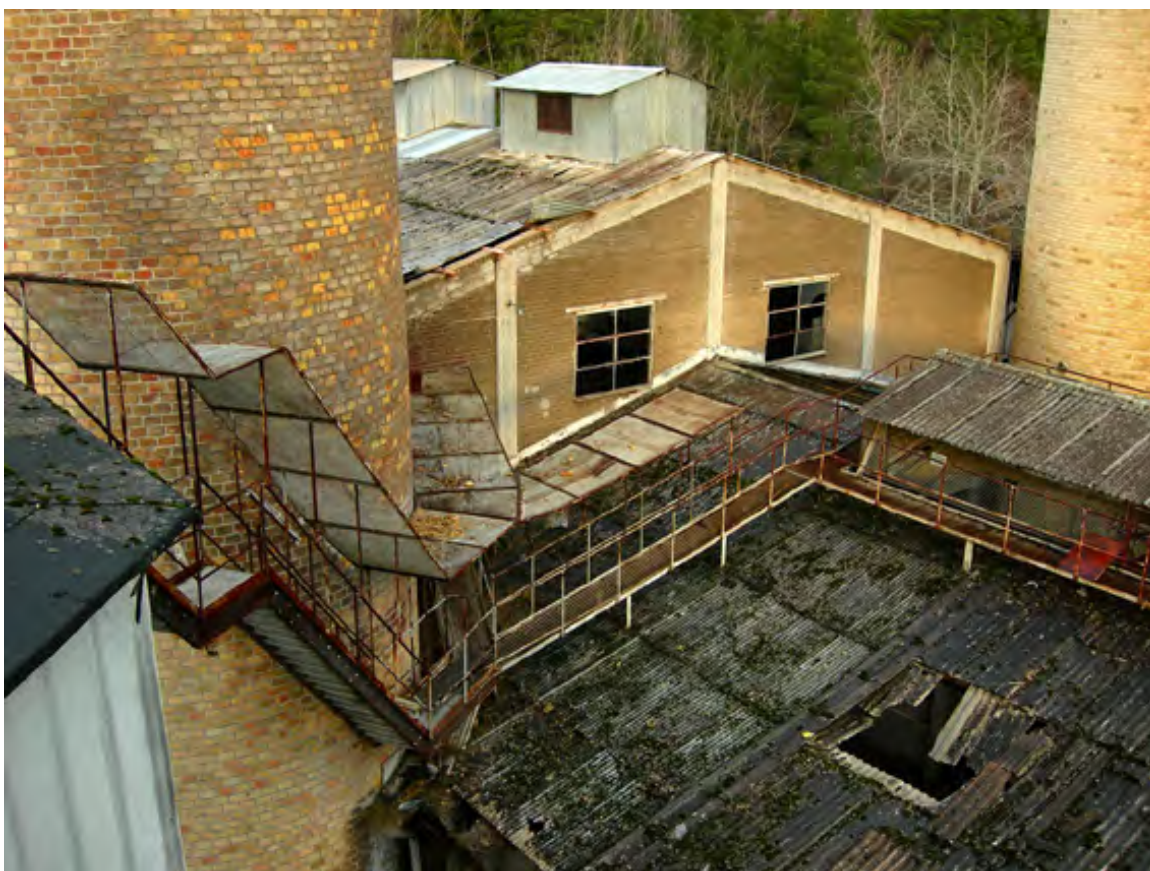
Trappan från slamsilorna leder ned till ugnshusets tak och fortsätter längs hela taket. Observera skyddsanordningen ovanför trappan som skall skydda mot fallande föremål. Mellan skorstenarna syns den södra fasaden på den byggnad som inrymde elektrofilteravdelningen i ugnshuset.
