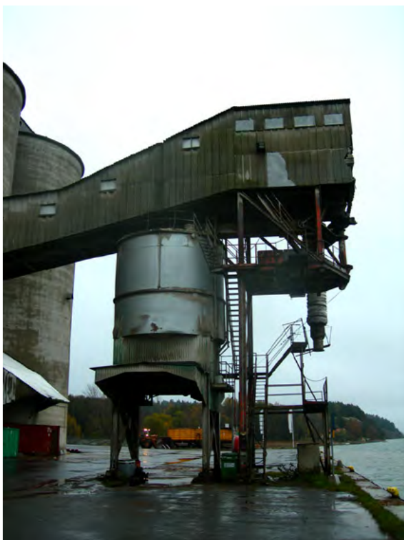
Utlastningsanordningen för löscement sedd från norr. Till höger den s.k. strumpan som användes för lastning av båtar. Under behållaren till vänster kunde bilar köra in för att lasta i bulk. Behållaren fanns inte från början. Utlastningsanordningen för båt var tidigare inklädd med eternit ända ned till marken.
