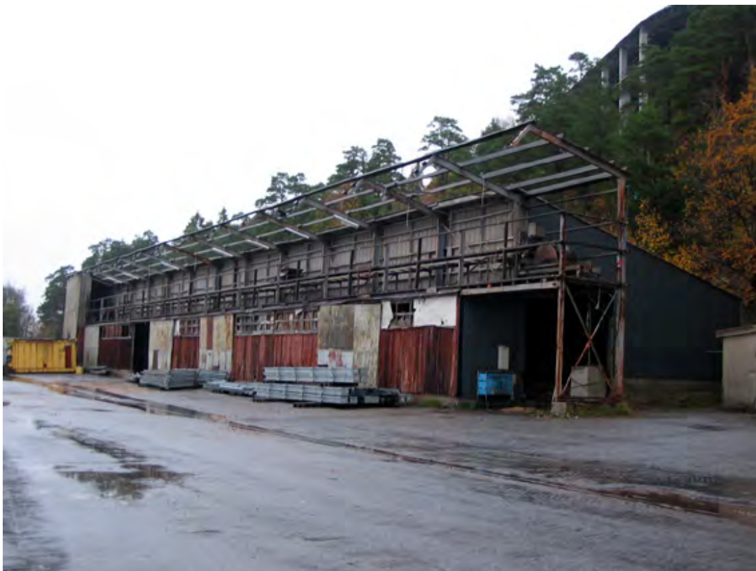
Magasinsbyggnad. Väggen av eternit som skyddade transportbandet längs med byggnaden har nästan helt försvunnit. Transportbandet finns dock kvar.
