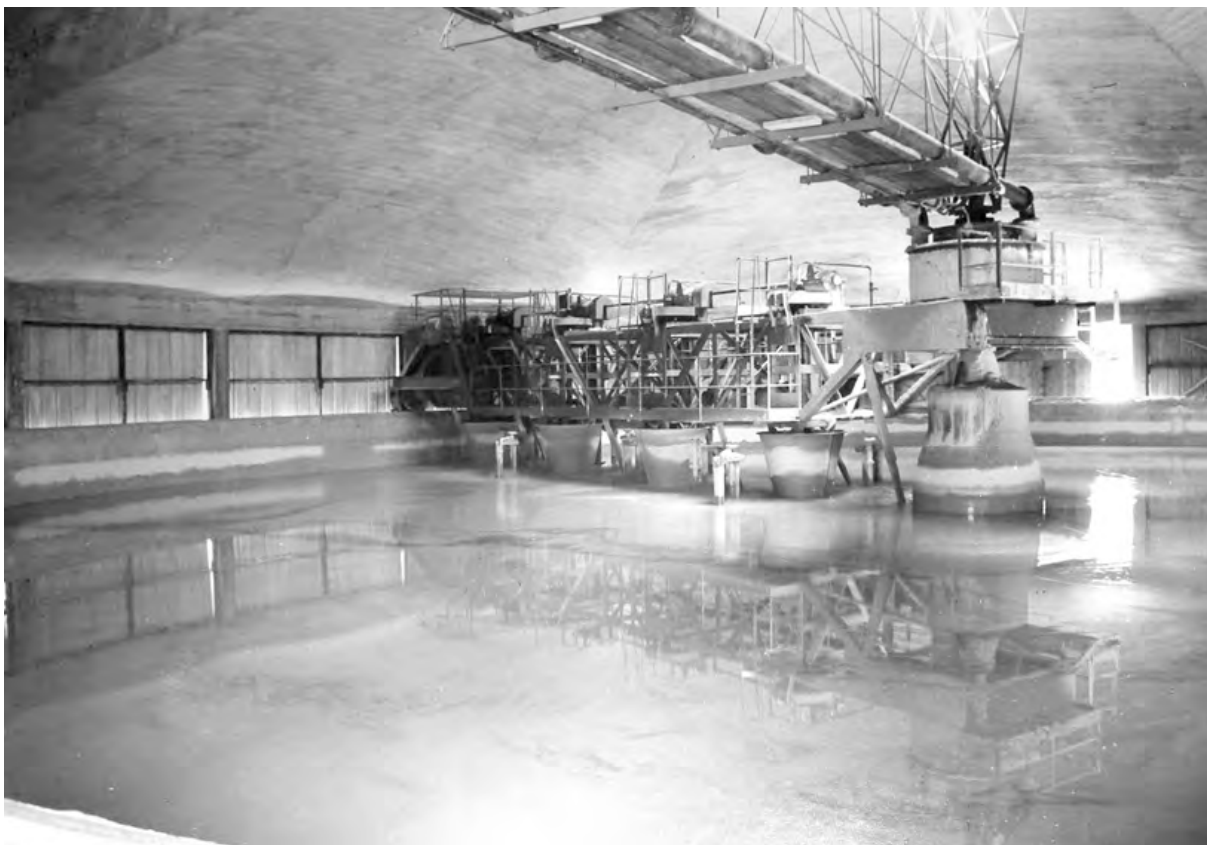
Interiör från slambassängen. Hit fördes det korrigerade råslammet.
