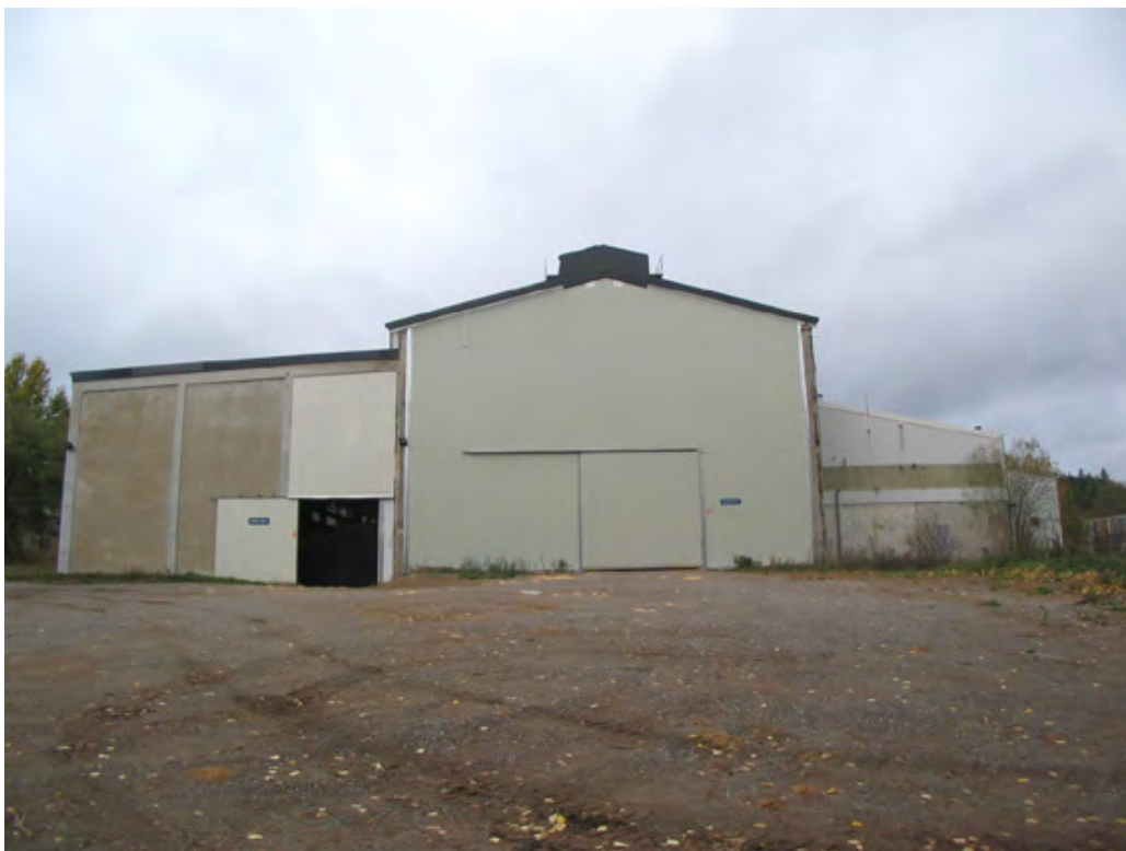
Lerlager och ugnshus som det ser ut idag. Fasaden är plåtklädd och har stora skjutdörrar insatta. Den södra delen av ugnshuset med sin vackra gavelfasad är riven och koltransportbanan mellan ugnshuset och lagerbyggnaden är även den riven. Fasaden är idag ganska intetsäggande och tråkig.
