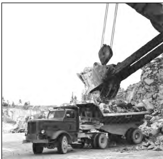
Denna bild från 1955 visar hur den brutna kalkstenen lastades med hjälp av en grävmaskin på en semitrailer.
