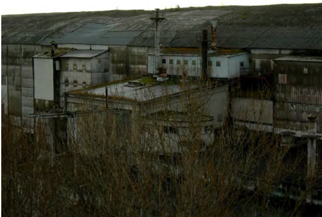
Anblicken av kvarnhusets fasader är en estetisk upplevelse. Byggnaden är idag ett pussel av olika grå ytor, fönsterband med asymmetriskt krossade rutor och ytor som trots sin ringa ålder fått en påtaglig patina. En av takets skador har lagats med ny plåt.
