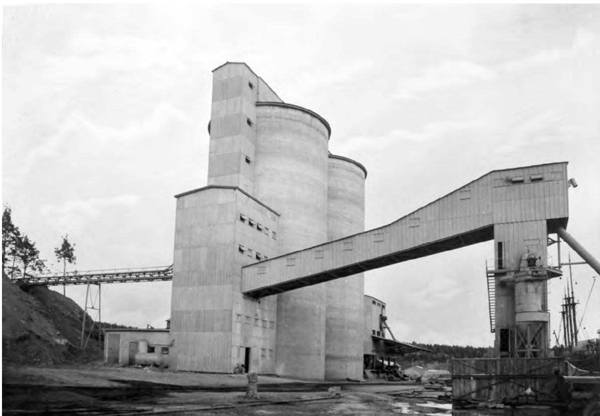
De två första cementsilorna med skopelevatorbyggnaden i förgrunden. Till höger syns den eternitinklädda utlastningsanordningen för lastning av löscement i båtar. Bakom silorna kommer de tre parallella rör där cementet transporterades pneumatiskt från kvarnhuset till cementsilorna.
