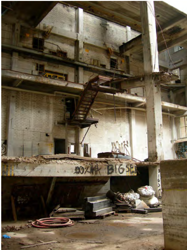
Insidan av ugnshusets norra vägg som ser ganska naken ut. Här syns att det rivits en del. I denna del av byggnaden matades slammet in i ugnarna.
