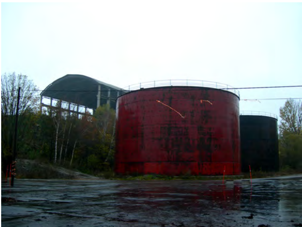
De två oljecisternerna finns kvar men deras isolering har till största delen fallit bort. Den äldsta cisternen är röd och syns närmast i bild. Ett litet hus med pumpanläggning finns bevarat mellan oljecisternerna.
