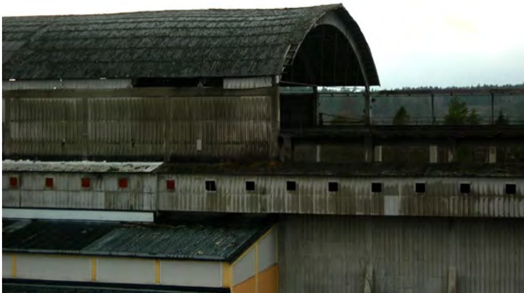
Lagerbyggnadens välvda tak där det slutar mot norr. Taktäckningen består av korrugerad eternit och väggarna är täckta med P.K.-eternit. Bilden visar också det inbyggda transportbandet samt en del av kvarnhuset.
