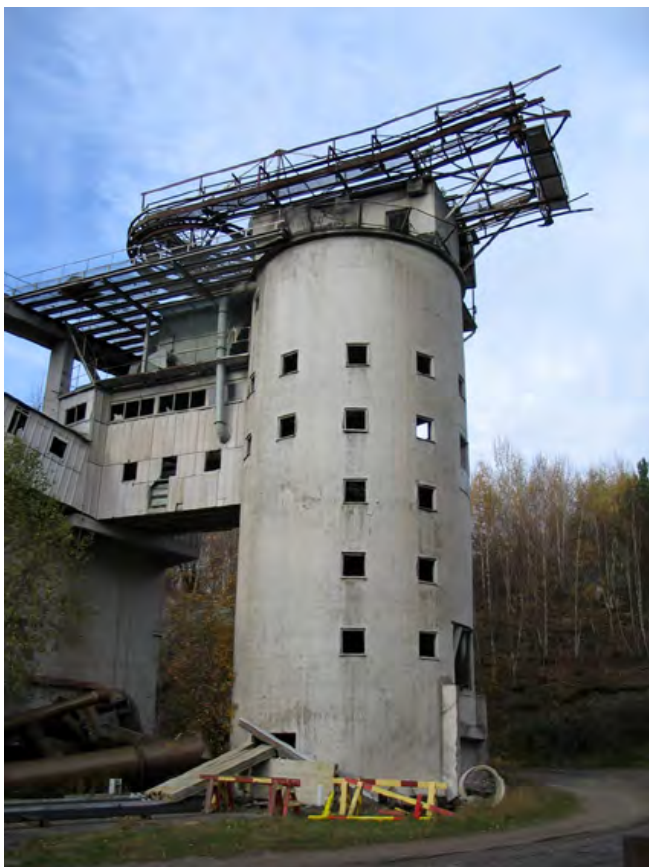
Linbanans avlastningsstation är en av anläggningens många fascinerande byggnader. Själva kablarna är kapade men konstruktionen för tippandet och vändandet av korgarna finns kvar högst upp. Tornet har en karaktär av fyrtorn eller modern borg av betong.
