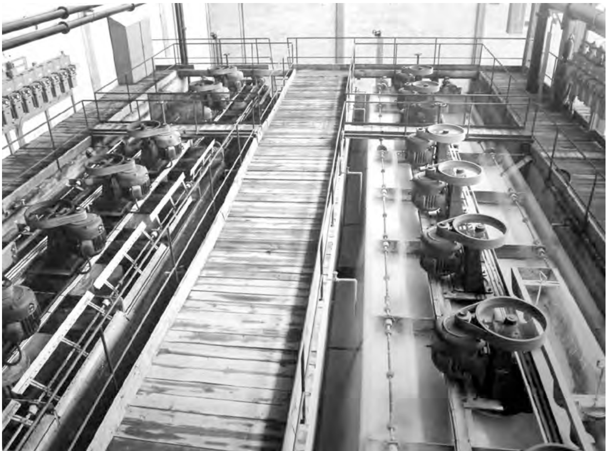
Två rader flotationsceller dit det grova slammet gick från centrifugerna för att genomgå skumflotation.
