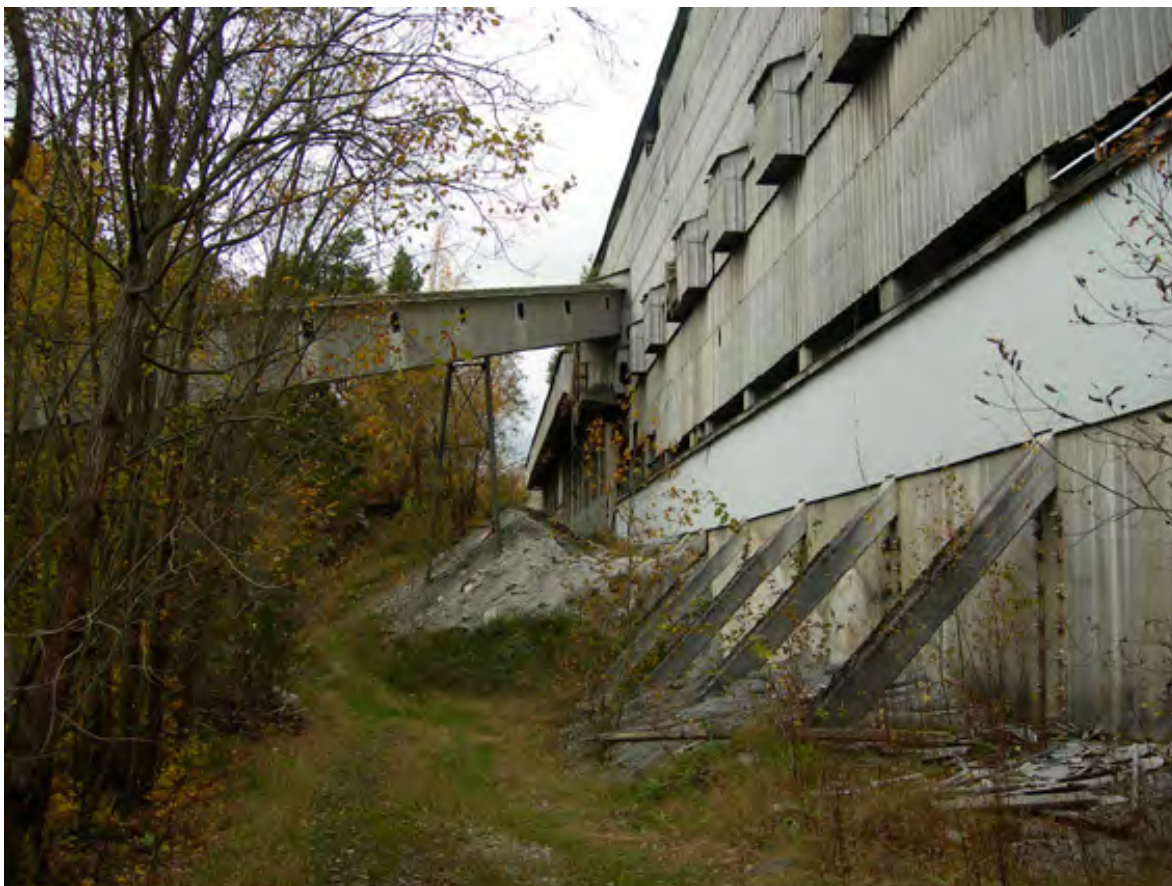
Den västra fasaden som vetter mot vattnet. Bilden visar också det transportband som användes för gods som anlänt till hamnen via fartyg.
