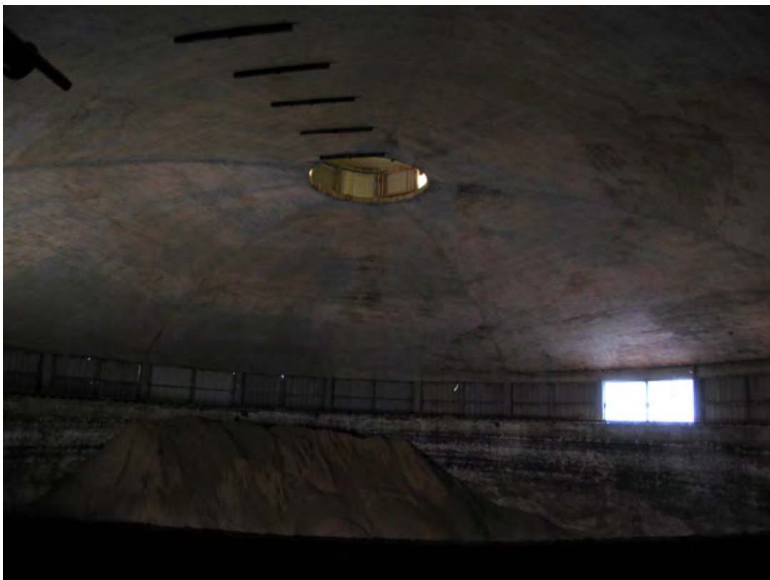
Interiör från slambassängen. Det kupolformade taket har en lanternin i mitten. Idag förvaras flis i byggnaden. För att kunna köra in flisen har en öppning tagits upp i fasaden. Detta skedde under företaget Bedminsters tid.
