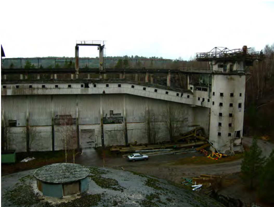
Linbanetornet sitter ihop med lagerbyggnaden genom inbyggda transportband. På bilden syns den östra fasaden längst mot norr med transportbandet som en utbyggnad med små kvadratiska öppningar. I förgrunden slambassängens runda betongtak. Det grå vädret bidrar till den stämning av övergivenhet och långsamt förfall som präglar hela anläggningen. Foto: LKU
