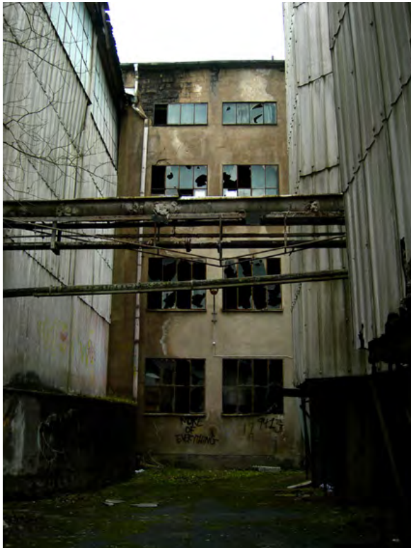
Flotationshusets norra fasad. Här har alla glasrutor krossats. Fasaden ligger inklämd vid slam-silor och ugnshus. Att gå här ger en känsla av att vandra i en smal och ruffig gränd. I förgrunden syns transportrör mellan ugnshuset och slam-silorna.
