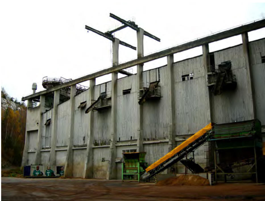
Fasaden på föregående bild syns här från andra sidan. Kalkstenen tippades via rännor ner från transportbandet i stora högar på den öppna planen. Över fasaden höjer sig en lyftanordning med en travers. Foto: LKU
