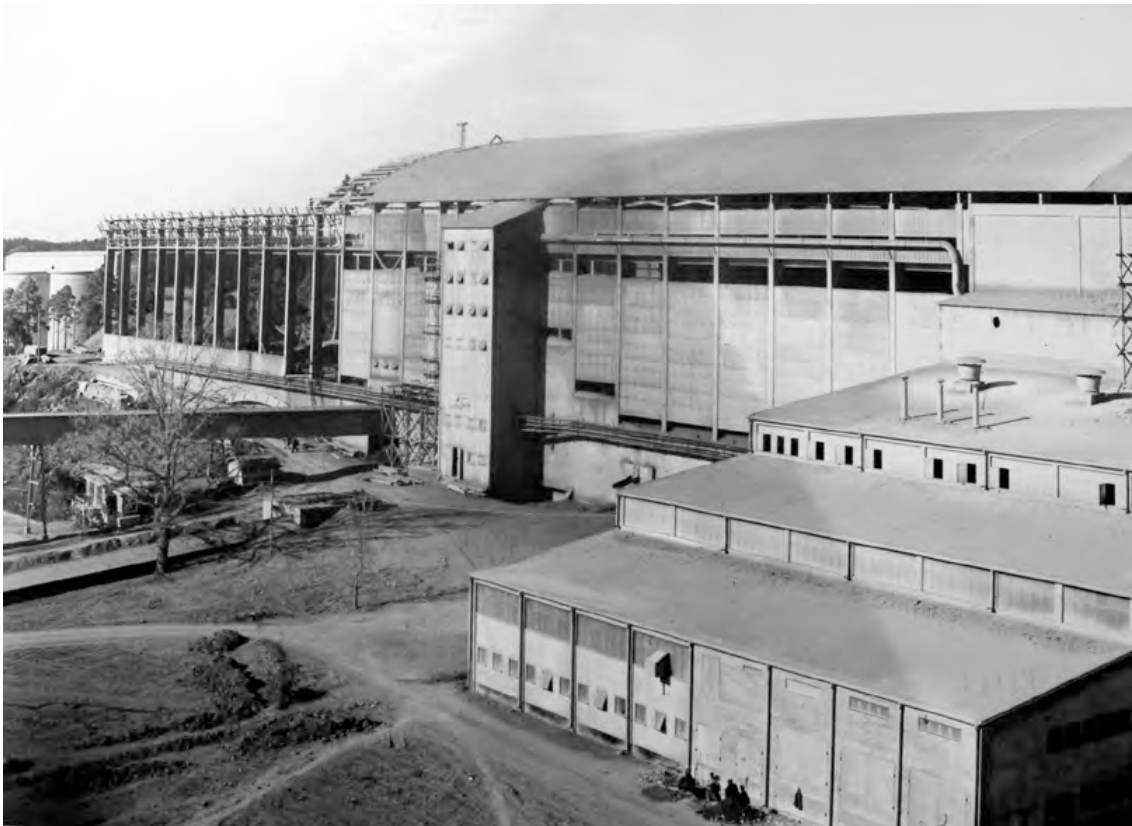
Lagerbyggnaden med kvarnhuset framför. Anläggningen är alldeles ny, prydlig och välordnad. I utbygg- naden på lagerbyggnadens fasad transporterades den brända cementklinkern upp med hjälp av skopele- vatorer för att sedan lagras i lagerbyggnaden.
