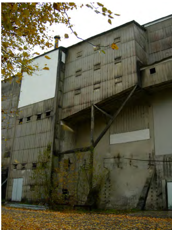
Utbyggnader på lagerhusets östra fasad. Till vänster syns den byggnad som rymmer skopelevator och trappa. Bakom fasaden på den smala utbyggnaden till höger finns ett transportband. Foto: LKU
