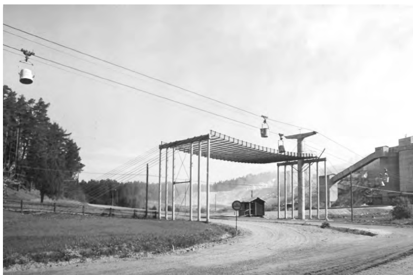
Ett vägskydd byggdes där linbanan korsade landsvägen. Till höger i bild kalkstenssilorna.
