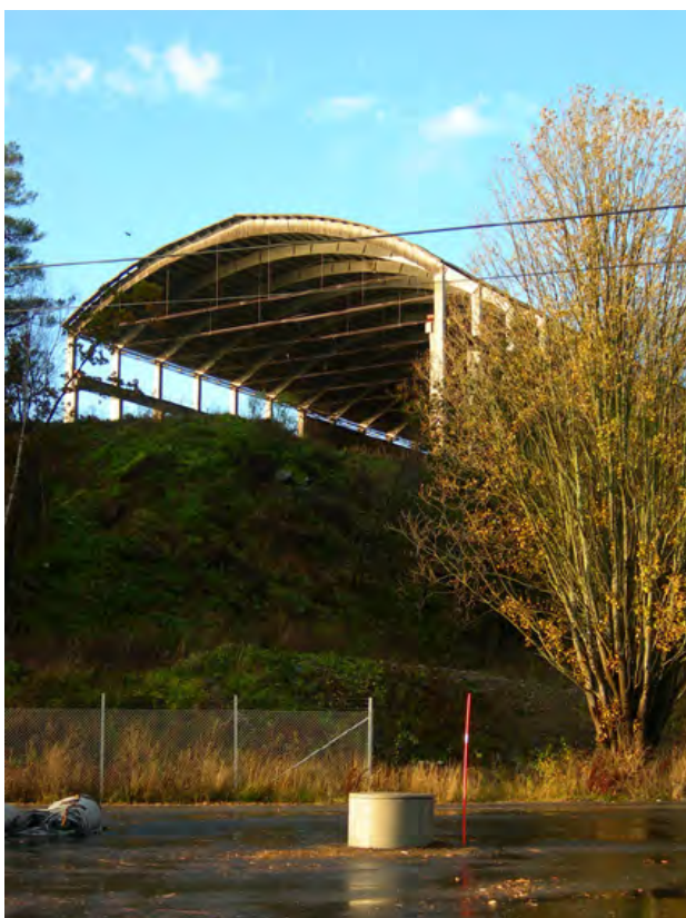
Lagerbyggnaden med sin takkonstruktion bestående av limträbalkar i bågform av fabrikat Töreboda.
