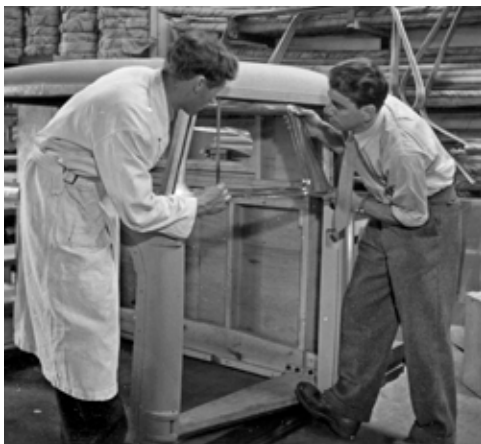
Personalen passar in dörrsektionen tillverkad av aluminium för det skjutbara sidorutan som kännetecknade HP-hytten.
