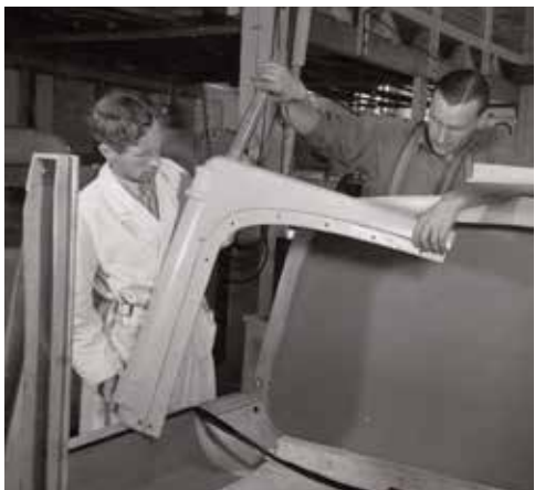
Hytten placeras liggande på rygg så att den främre hytt dörrstolpen med a-stolpen av aluminium kan passas in på plats.
