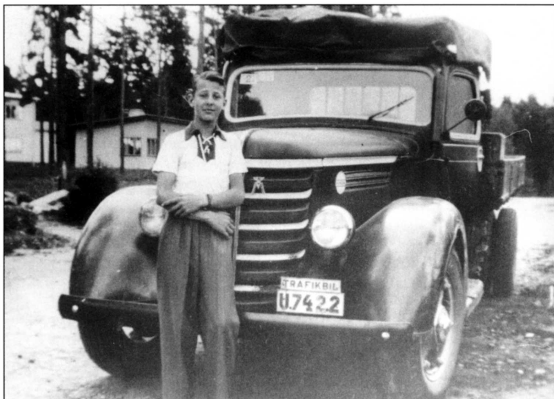
Federal typ 180C från 1939. Köptes av Gustav Jansson i juni 1939. Ch nr 98553. Den kördes på kolgas, ett Hässleholmsaggregat. Motorn var på 86 hk. I juni 1949 sändes den till skrot. Lastförmågan var strax över tre ton. En av Gustavs äldre söner, Olov, står framför bilen.
