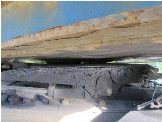
Dragbilen vinklad i förhållande till trailern, olika tvärfall för dragbil och trailer, extra stor påkänning på vändskivans bakre vänstra ytterkant. Foto: Eget
